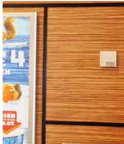
Pro Gaststätte genügt ein Schadstofffühler
