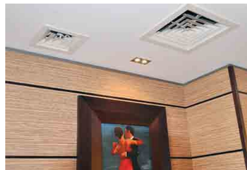
Der Ionisator sitzt direkt an den Auslässen
